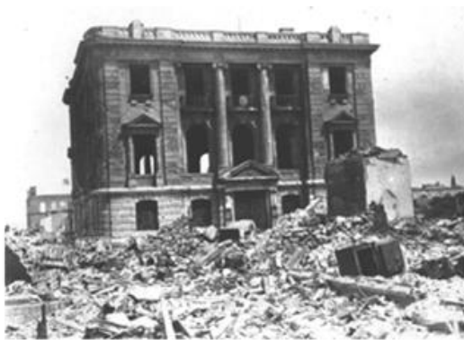
Figura 2. a) Casa antisismica con rinforzi angolari nei vani interni, progettata da Pirro Ligorio dopo il terremoto di Ferrara del 1570; b) Edificio in muratura sopravvissuto al terremoto di Tokio del 1923 di magnitudo 7,9, anche per resiliente interazione con il terreno.
