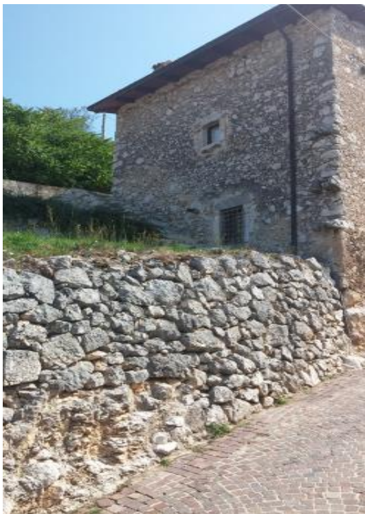
Figura 3 a) Tipica muratura a secco e con malta; b) legame chimico fra il grassello e la pietra calcarea che rende resistente per coesione le murature fatiscenti.
