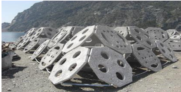
Figura 11a Habitat ittici artificiali tipo sabbie litificate che imitano le barriere coralline (Dini 2020) o reef balls anche di varie forme a vaso forato o a reticolo spaziale in cemento armato.
